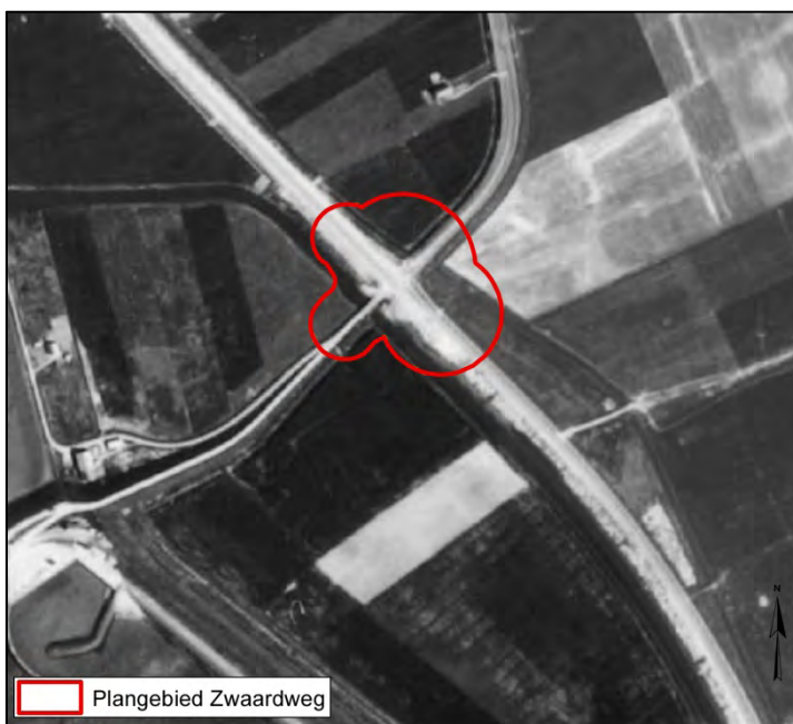
Afbeelding 59 Ligging van het plangebied Zwaardweg op de luchtfoto uit 1959. Schaal 1:7.500. Bron: Geoloket Provincie Zeeland.
